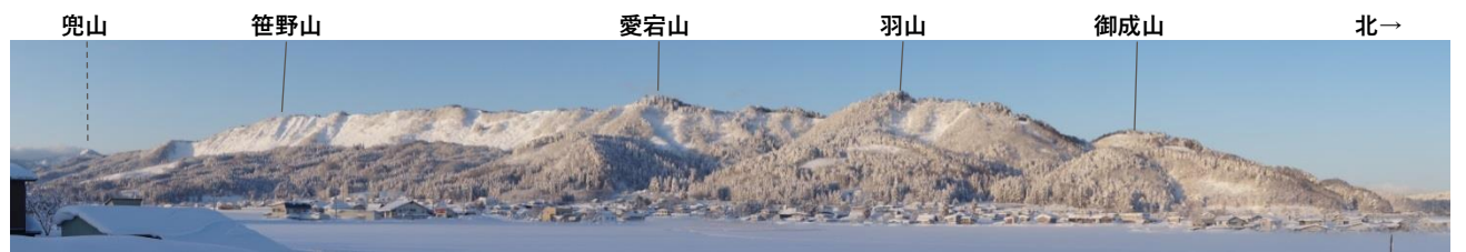
写真1. 米沢市街地から見た斜平山山塊東斜面。(2013年2月26日撮影) 新雪の白さが愛宕山から笹野山にかけての崩落崖と崩積土の境目を際立たせている。また、愛宕山、羽山、御成山の北東に張り出した地形の盛り上がりの状況がわかる。低地との境界部分が斜面に沿って盛り上がっているように見える。
