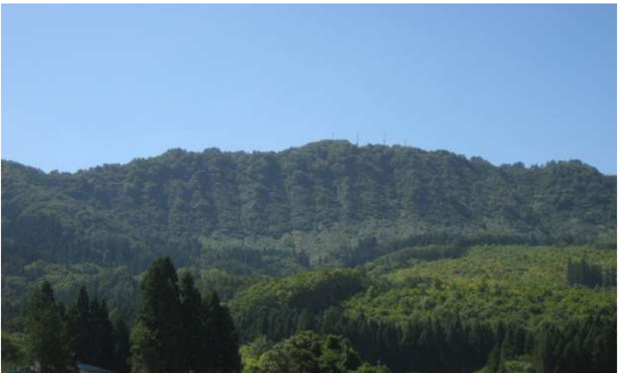
写 8 笹野山東斜面(屏風のように切り立った崩落崖).
